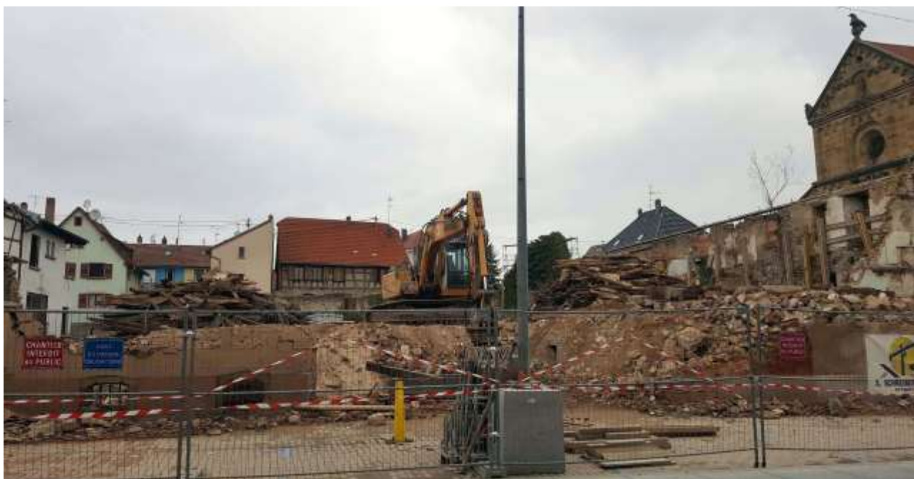
Le Meyerhof, vu depuis la rue du Général-de-Gaulle, après les démolitions (photo SCMHA)
