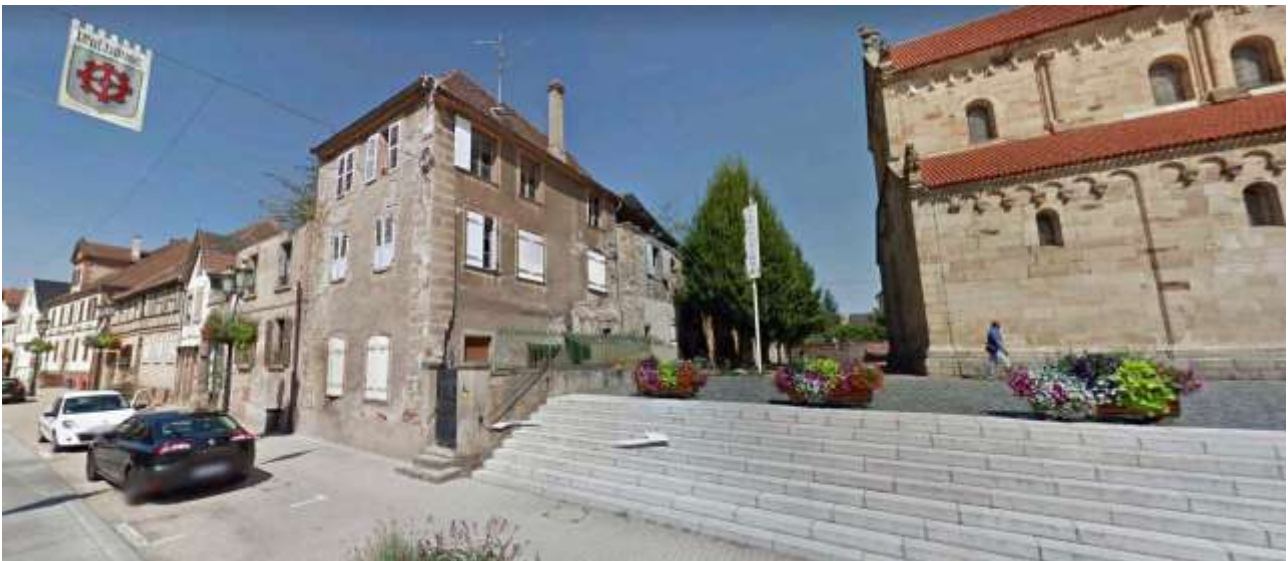
Le Meyerhof, vu depuis la rue du Général-de-Gaulle, avant les démolitions (photo Google Street)
