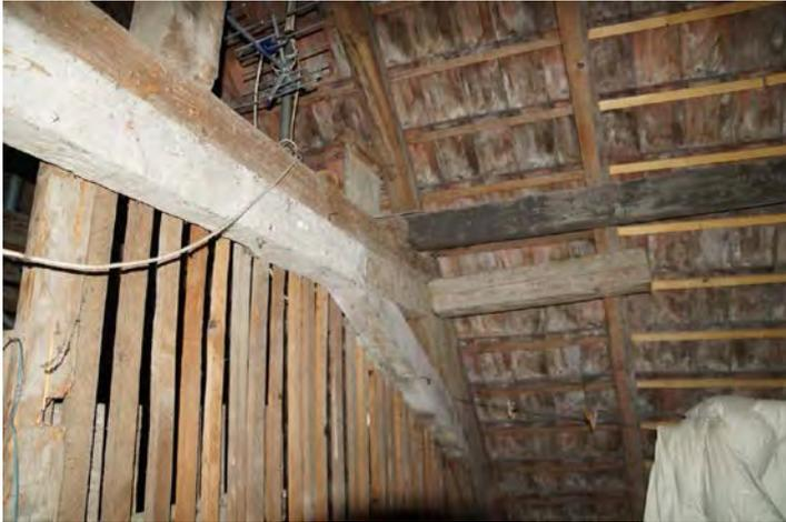
*Figure 6. Assemblage de ferme de charpente*
