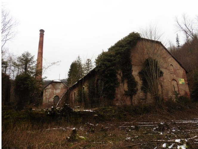
Vue actuelle du laminoir de Framont. (photo de l'auteur)
