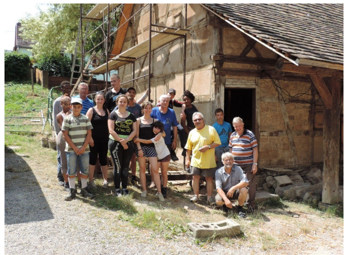
L'équipe du chantier devant l'ossature de la maison provenant de Blasenheim en 2016 (photo remise par l'auteur)
