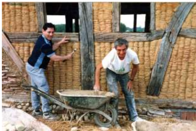
La réalisation du remplissage en torchis de la maison d'Artolsheim (1561) reconstruite à l'écomusée : Marc Grodwohl aux côtés d'un visiteur fier de participer (fictivement) aux travaux.
