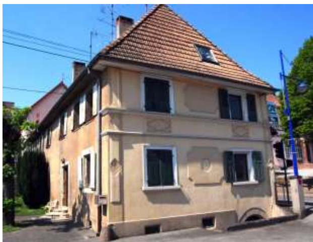
Vue du pignon est et de la façade sud (photo : M. Grodwohl).
