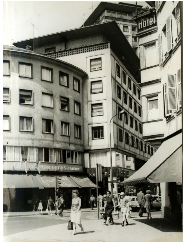
Vue vers 1965 de l'ensemble immobilier construit entre 1955 et 1958 par les architectes Charles Gustave Stoskopf, Walter Oehler et Alfred Fleischmann place de l'Homme-de-Fer, place Kléber et rue du Fossé-des-Tanneurs à Strasbourg ; à l'arrière-plan, la tour Valentin-Sorg (photo : Wollenschlaeger ; extrait de http://www.archi-wiki.org )
